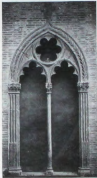
Finestra di palazzo Grati.
